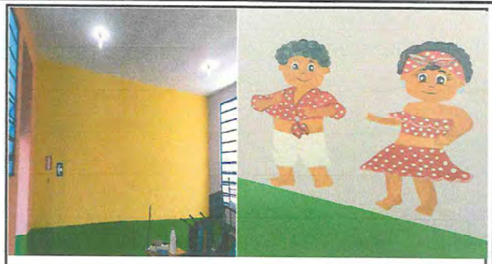
Foto 2: Se finaliza la pintura de paredes de las aulas, el zócalo y los murales didácticos.
