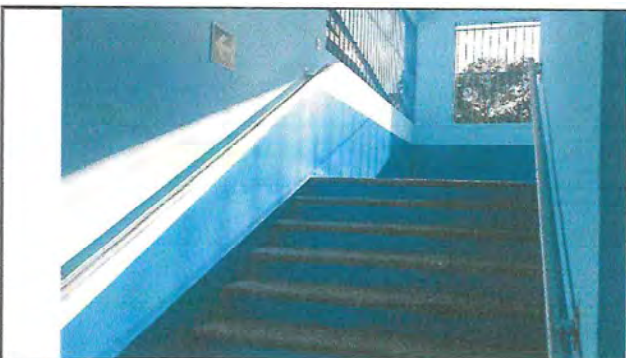
Foto 5: Se finaliza el refuerzo con acero inoxidable el pasamanos en gradas.
