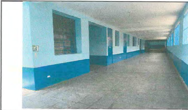
Foto 3: Se culmina la pintura de paredes y zócalo de los corredores y muros
