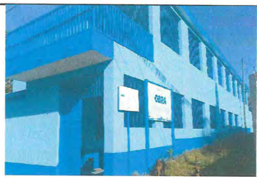
Foto 4: Se culmina la pintura de paredes y zócalo de la parte frontal de la escuela.
